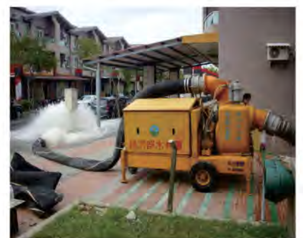
การสูบน้ำออกจากชั้นใต้ดิน
